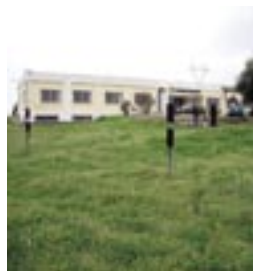
Εικόνα 2: Ενίσχυση της ασφάλειας σε πηγή βιομηχανικής μονάδας
