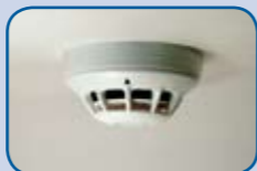
Πυραυλιονευστήρας ιονισμού με ραδιενεργό υλικό
