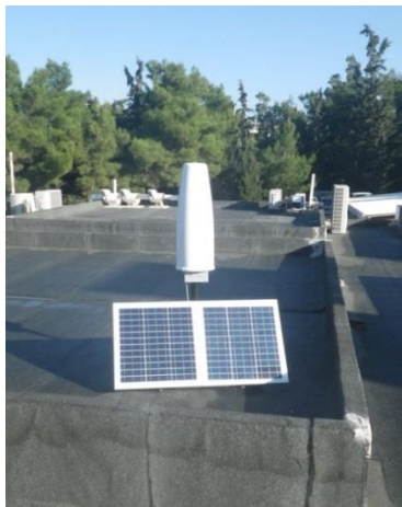
ΑΓΙΑ ΠΑΡΑΣΚΕΥΗ Κτίριο ΕΕΑΕ (Συχνοεπιλεκτικός)
