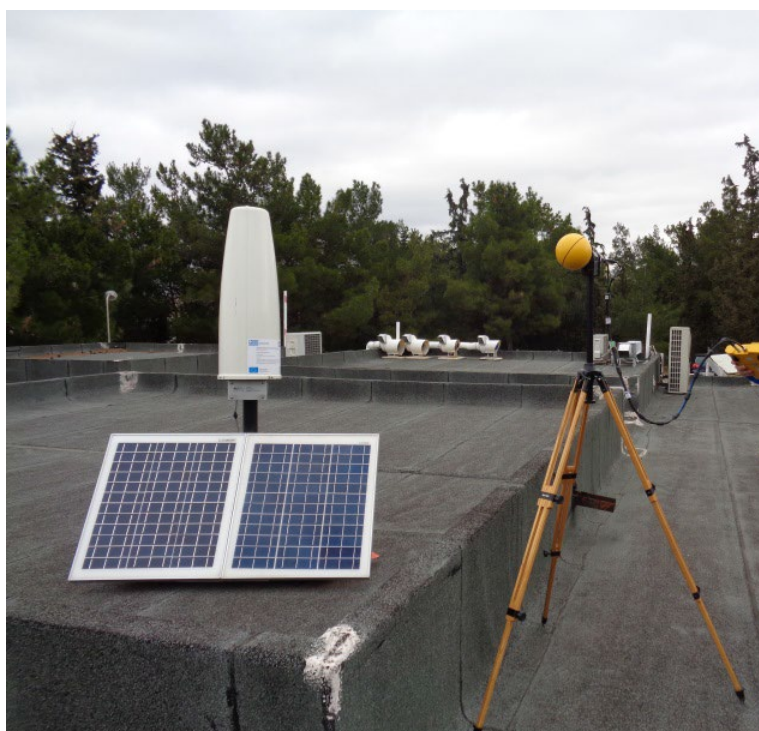
Φωτογραφία 3: Διαδικασία ελέγχου καλής λειτουργίας
