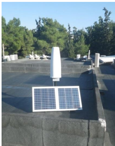
ΑΓΙΑ ΠΑΡΑΣΚΕΥΗ Κτίριο ΕΕΑΕ (Συχνοεπιλεκτικός)
