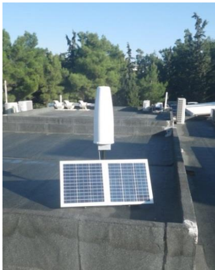
ΑΓΙΑ ΠΑΡΑΣΚΕΥΗ Κτίριο ΕΕΑΕ (Συχνοεπιλεκτικός)
