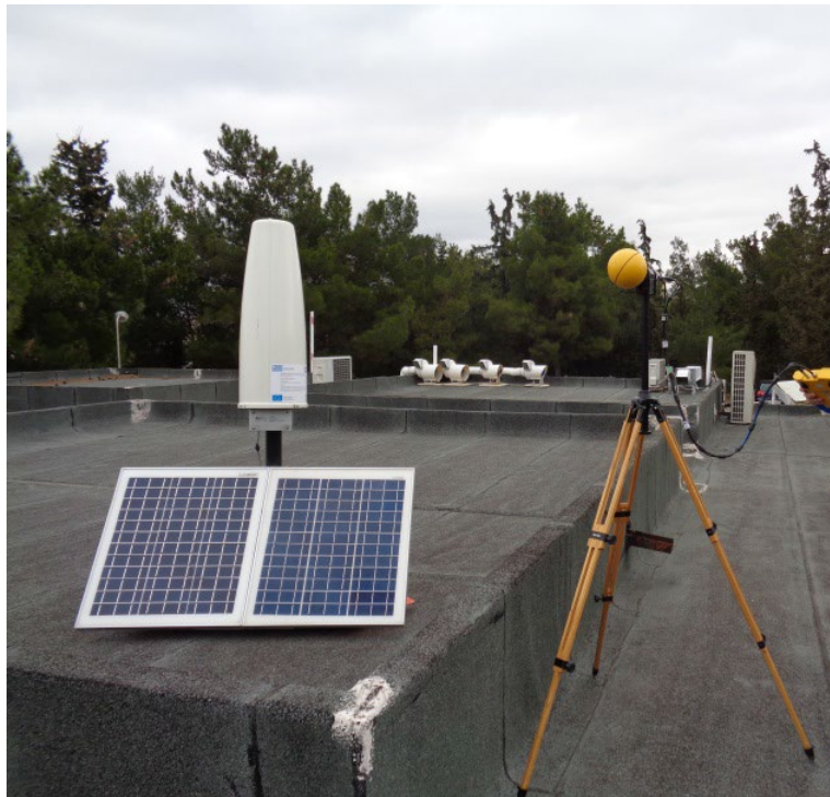
Φωτογραφία 3: Διαδικασία ελέγχου καλής λειτουργίας των σταθμών μέτρησης
